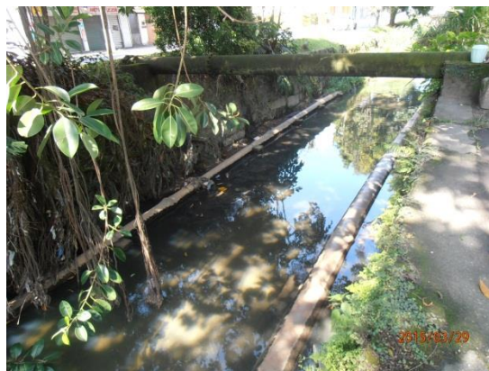
Dutos para coleta do esgoto
